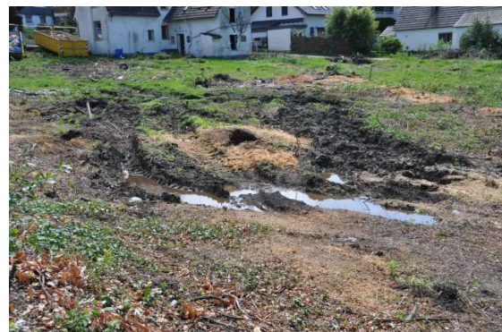
Bei der Baufeldfreimachung stark verdichteter Boden mit tiefen Fahrspuren. Hier wurde keine Vorsorge betrieben. © Ingenieurbüro Feldwisch
