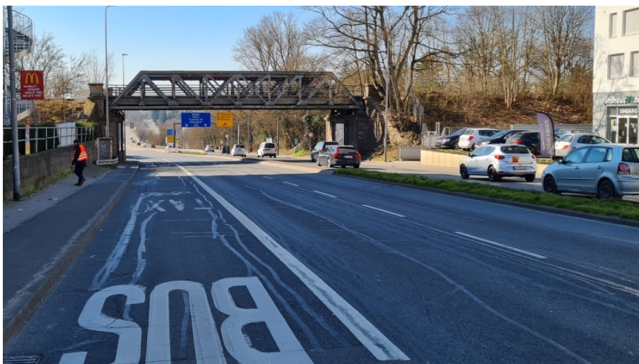
Abbildung 28: Eisenbahnbrücke Schiersteiner Straße (km 4,142)
