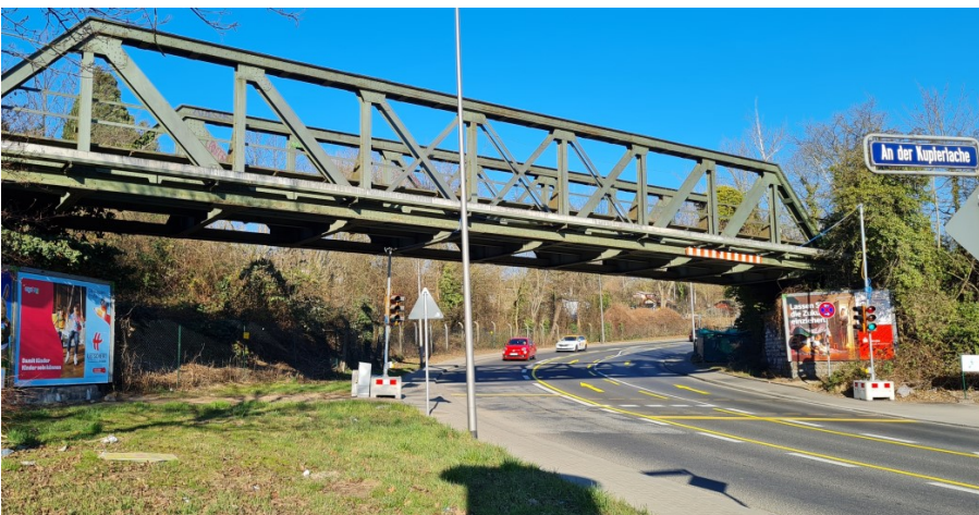
Abbildung 22: Eisenbahnbrücke über dem Theodor-Heuss-Ring (km 1,2)
