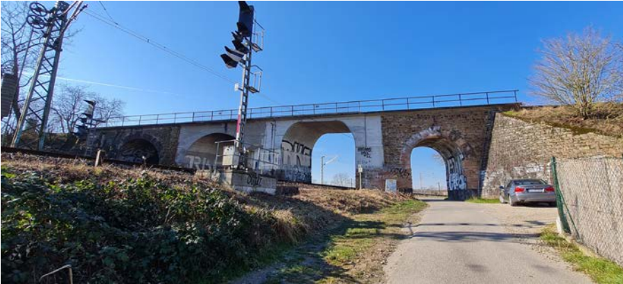
Abbildung 19: Brücke über die Bahnstrecke Wiesbaden Hbf. – Wiesbaden-Bieblich sowie die Kronberger Straße
