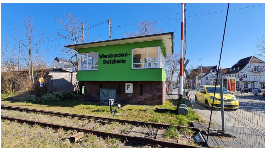
Abbildung 29: Stellwerk Wiesbaden-Dotzheim am Bahnübergang Wiesbadener Straße
