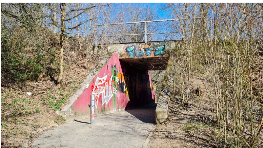
Abbildung 32: Eisenbahnbrücke Dolomitenstraße (km 7,318)
