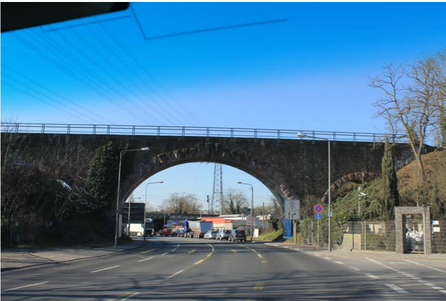
Abbildung 18: Brücke über die Mainzer Straße
