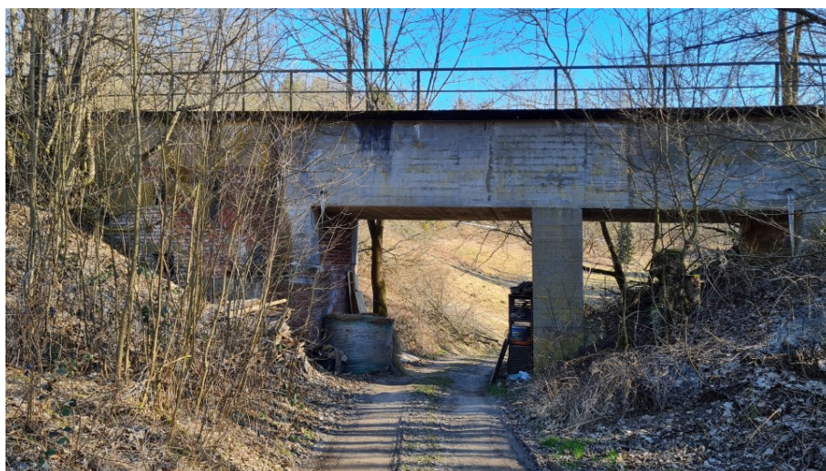
Abbildung 39: Wegbrücke unterhalb der Kirche St. Peter auf dem Berg
