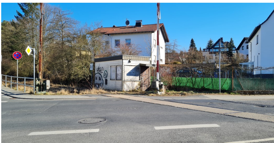
Abbildung 37: Schrankenposten (Posten 5) in Bleidenstadt
