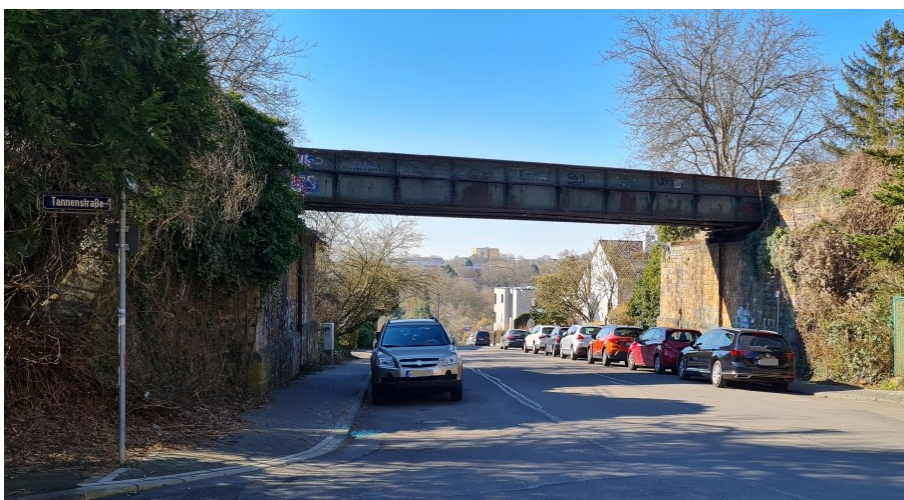
Abbildung 26: Eisenbahnbrücke Grundmühlenweg (km 3,371)
