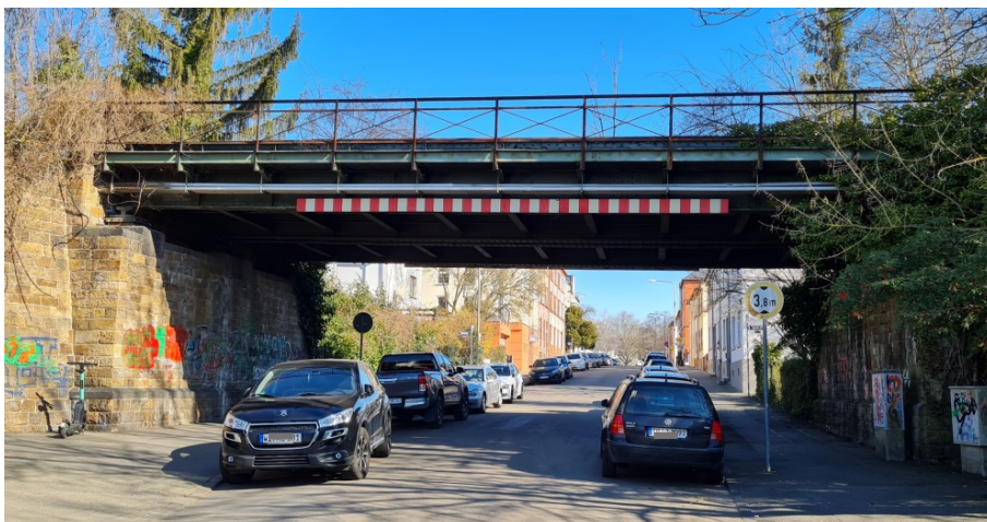
Abbildung 27: Eisenbahnbrücke Wiesenstraße (km 3,684)
