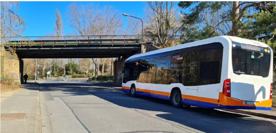
Abbildung 24: Brücke über die Steinbergerstraße (km 2,905)
