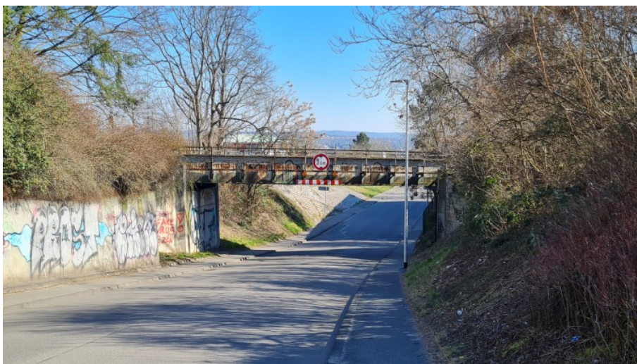
Abbildung 31: Eisenbahnbrücke Flachstraße (km 6,540)
