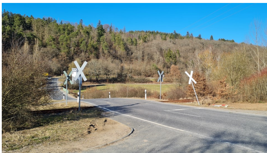
Abbildung 40: nur mit Andreaskreuzen versehener Bahnübergang an der Straße nach Seitenhahn
