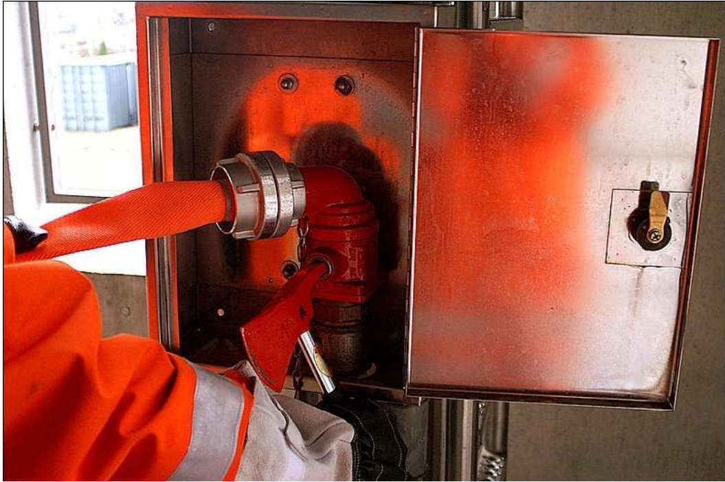
Schlauchanschlusseinrichtung DIN 14461-5 für Löschwasseranlage (Steigleitung) „trocken“ (Bildquelle LFS Baden-Württemberg)
